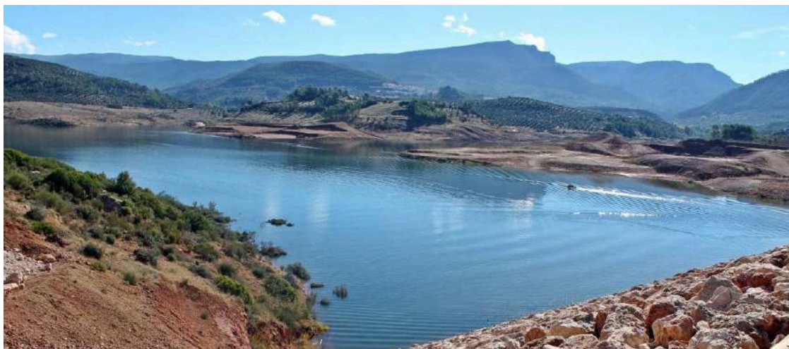
Presa de Siles (Jaén)CHG
